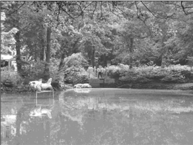
Abbildung 6: Der Wasserstand am 5. Juni 2003. Der Wasserspiegel reichte dem Fisch – Hammer Rudi - zuvor bis zum Bauch. Links neben dem Mönch die mit Sandsäcken abgedichtete Schadensstelle.
